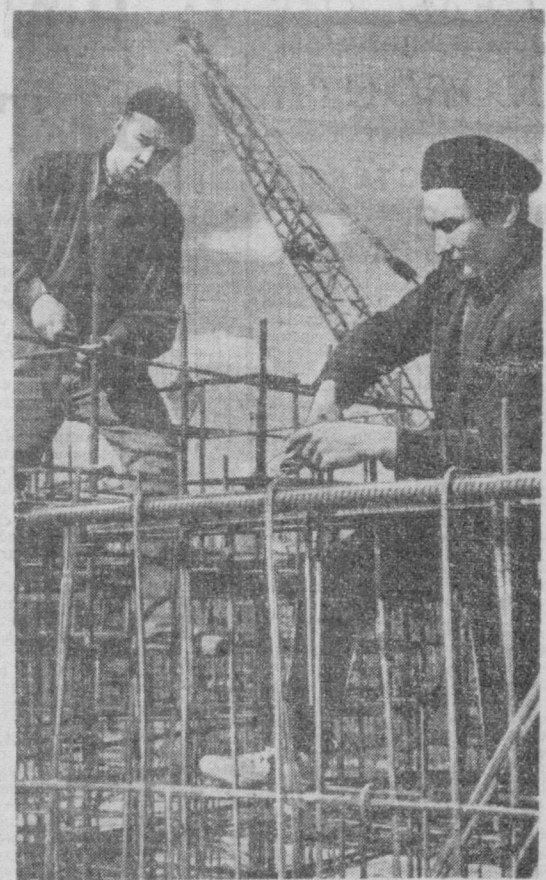
На строительстве Ташкентской ГРЭС бетонруется основание фундамента под всеюм котел и ведутся арматурные работы. На снимке: арматурщики Анатолий Войнов и Карим Сафаров вяжут арматуру.
