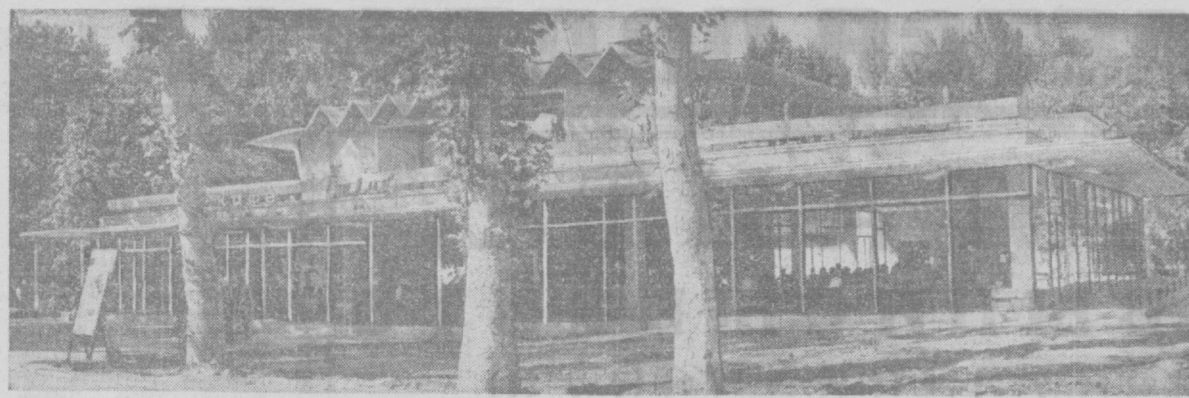
В Ферране открылось молодежное кафе «Юности». Расположенное на двух этажах, оно может одновременно принять 550 посетителей. Отлично поработали строители СМУ-11 стратреста № 14: они на месяц раньше срока сдали сооружение в эксплуатацию.
