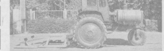
Давлат машина — синиш станцияларида ўтказилган текширишлар пахта териш агрегатлари шпинделларини тозалаш учун иш вақтини 30 проценти сарфанишини кўрсатади. Бу «авангари ке-ма»лар унумдорлигини кес-кин қамайтиради.
