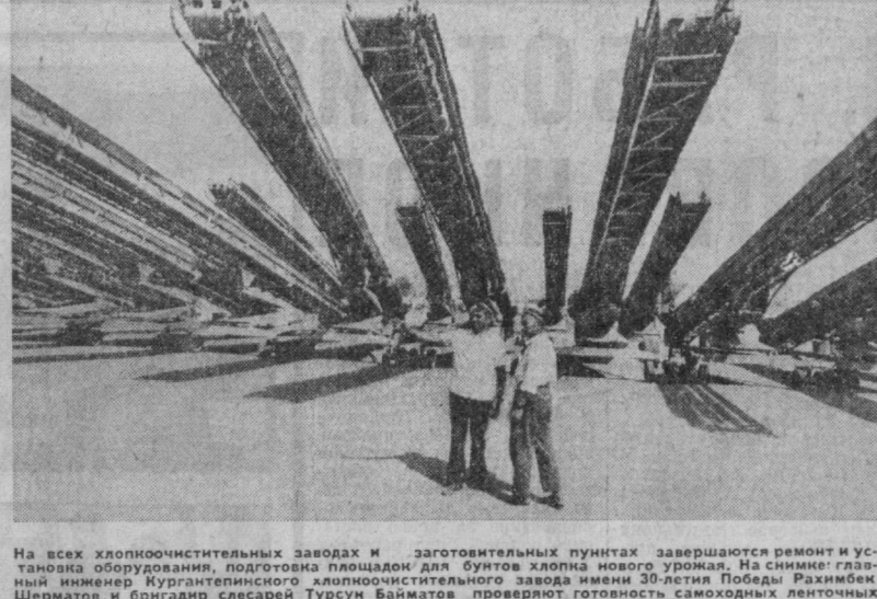
На всех хлопкоочистительных заводах и заготовительных пунктах завершаются ремонт и установка оборудования, подготовка площадок для бунтов хлопка нового урожая. На снимке: главный инженер Кургантинского хлопкоочистительного завода имени 30-летия Победы Рахимова Шерматов и бригадир слесарей Турсун Байматов проверяют готовность самоходных леточных транспортеров.
