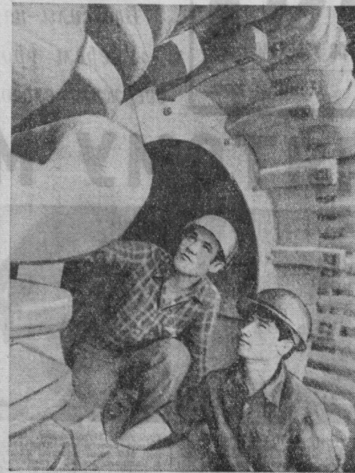
Горячая пора сейчас у монтажников и строителей Сырдарьинской ГРЭС. Здесь успешно ведется монтаж четвертого котлоагрегата и турбогенератора, которые намечено сдать в эксплуатацию в декабре нынешнего года. На снимке: слесари И. Ситниев и А. Джуманкулов ведут монтаж четвертой турбины. Фото А. ГОРОХИКА (УЗТАГ).
