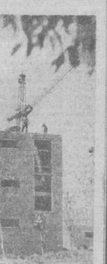
Строительство школы на 950 мест в совхозе «Самарканд» Сырдарьинской области. Фото Д. МИХАЙЛОВА.
