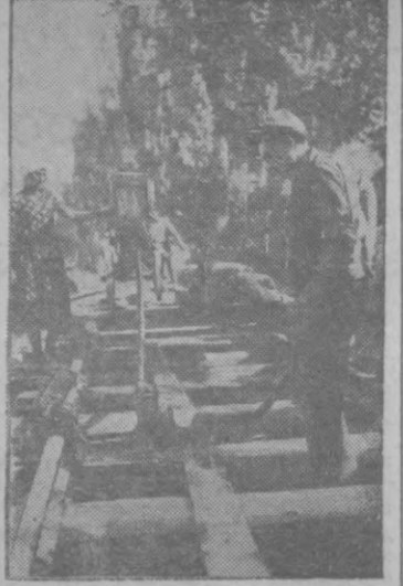
Прокладка нового ширококолейного трамвайного пути по улице Сталина. Фото В. Позняк.
