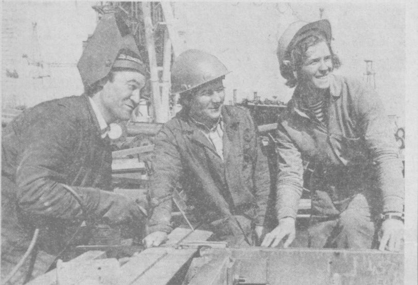
На снимках: идет монтаж телебашни; лучшие монтажники на укупительной сборке лифтовых шахт из бригады Б. В. Соболева (слева направо): Р. Карабаев, В. Данилов и С. Авакумов. Фото А. ПАЛЕХОВА.
