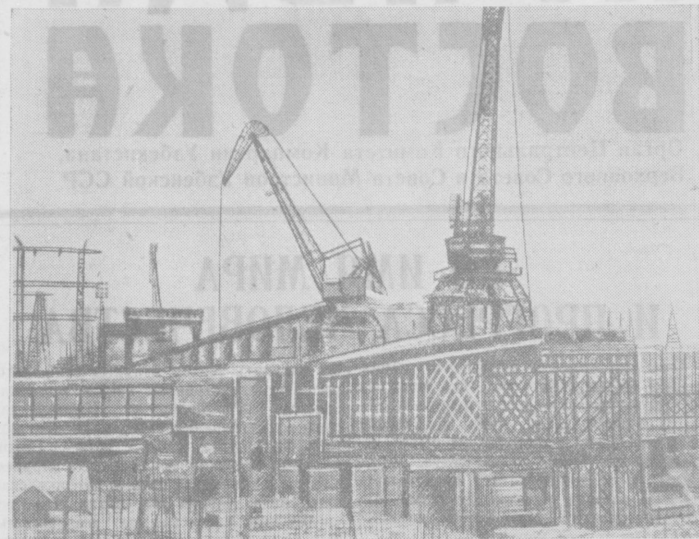
Молотов. Широким фронтом развернулось строительство второй очереди Камской ГЭС. Беспрепятственным потоком к котловану движутся автомашины с бетоном и пиломатериалами. Строители ведут бетонирование фундаментной плиты ГЭС, устоя и левобережной стены нижнего и верхнего бьефов. Гидромонтажные закончили сборку эстакады. В 1955 году строители должны уложить в сооружение четвертой секции 165 тысяч кубометров бетона и ввести в эксплуатацию шесть агрегатов последней секции Камской ГЭС. На снимке: бетоноукладочная эстакада четвертой секции водосливной плотины ГЭС. Фото Б. Визуля (Фотохроника ТАСС).
