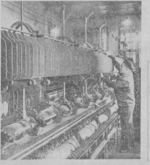
Выполняя постановление партии и правительства о дальнейшем подъеме текстильной промышленности, коллектив завода «Таш-Текстильмаш» увеличивает выпуск новых высокооборотных, высокопроизводительных ирутильных, ромичных машин. На СНИМКЕ: сборка новой прядильной машины «ПЛ-66» в экспериментальном цехе.
