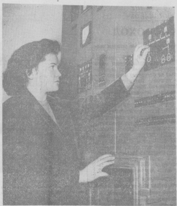
Наманганский энергокомбинат перешел на телемеханическое управление гидроэлектростанциями. Это делается одним человеком с центрального пульта управления. НА СНИМКЕ: дежурная В. Судаева у пульта телемеханического управления.
