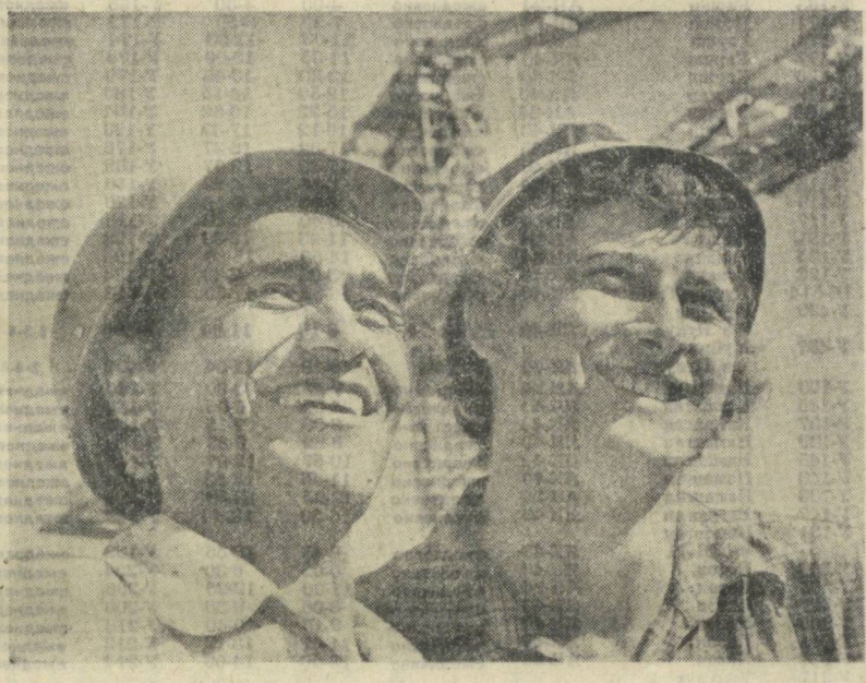
С удвоенной энергией ведутся работы на строительстве Газалкентской ГЭС. В конце года под промышленную нагрузку будет поставлен первый энергоблок. На снимке: члены комплексной бригады строителей, сооружающих здание электростанции, бетонщики Д. Мирсайтов и В. Рукумовы. Ежедневно они норму выполняют на 160—180 процентов.
