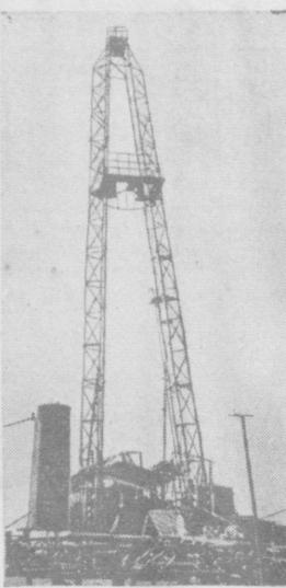
В Бухарской области ширится разведка месторождений природного газа. Геологи получают в свое распоряжение совершенную технику. На снимке: буровая установка «БУ-75-БР», смонтированная в Газлинской узрезультативной партии нефтегазведки. Она значительно облегчена, более компактна и удобна в эксплуатации.
