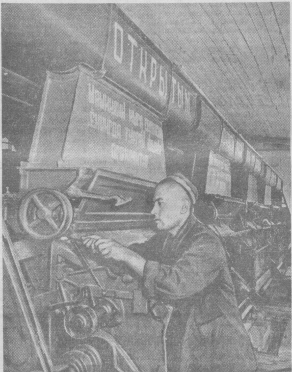
Анжиганский хлопкозавод № 1 заканчивает ремонт оборудования и готовится к приему сырья нового урожая. На снимке: слесарь Х. Бадалбаев ремонтирует пухотделительные агрегаты.
