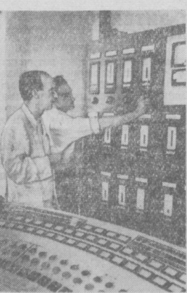
Завершена телемеханизация и автоматизация Куйган-Ярской плотины, регулирующей мощный водный поток Кара-Дарьи и Нарына — главных источников Большого Ферганского канала. Электрическую энергию агрегат подает станция, построенная на одном из перепадов этого же оросителя. На снимке: киноплотинер легко регулирует подачу воды в канал. В ближайшем будущем автоматизация будет завершена на протяжении всех 360 километров. НА СНИМКЕ: у центрального пункта управления.
