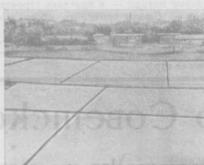
На снимках: 1. Железобетонные крупнопанельные плиты, уложенные над третьим этажом строящейся школы. 2. Подъем крупнопанельной железобетонной сборной плиты башенным краном на чердачное перекрытие.
