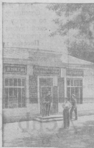
В Ваудильском районе, Ферганской области, большое внимание уделяется културно-бытовому строительству. Здесь уже построено много жилых домов в колхозах и в районном центре, магазины и другие културно-бытовые помещения. На снимке: новое здание книжного магазина в селе Ваудиль. Фото Байков. (Фотохроника УЗТАГ).
