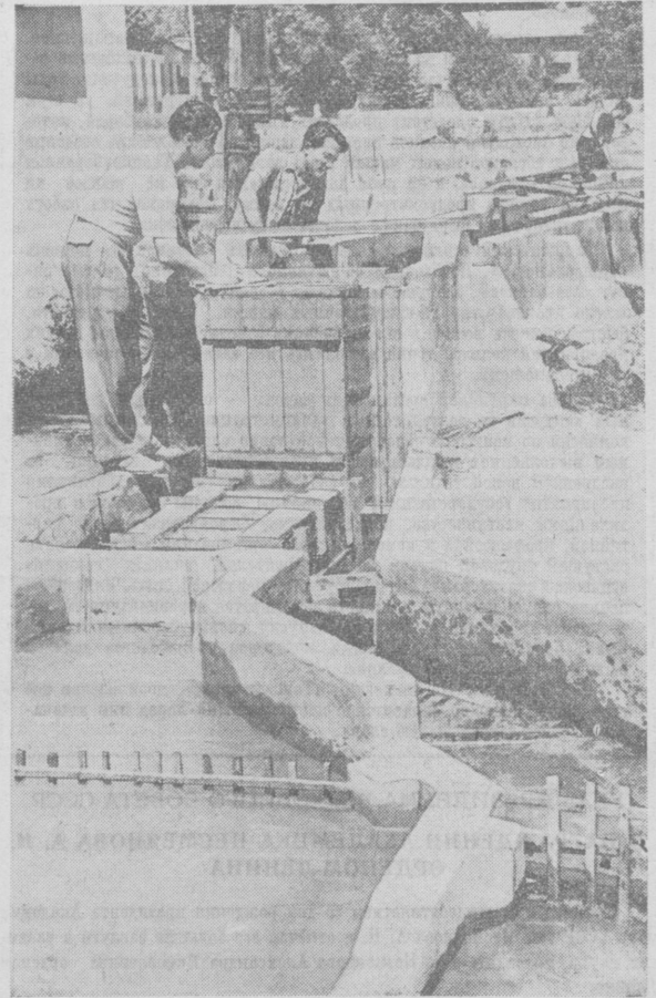
В Среднеазиатском научно-исследовательском институте ирригации заканчивается исследование попадания наноса в турбины средней ГЭС. Работы ведутся на специально изготовленной действующей модели. Руководит исследованием кандидат технических наук М. Б. Селеметов. На снимке: аспирант Е. Г. Филиппов (слева) и лаборант В. М. Легкодымов у действующей модели.
