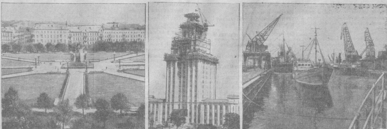
На снимках: 1. Площадь имени Ленина в Вильнюсе. 2. Строительство высотного здания Республиканского Дома колхозников в Риге. 3. В Таллине. (Фотохроника ТАСС).
