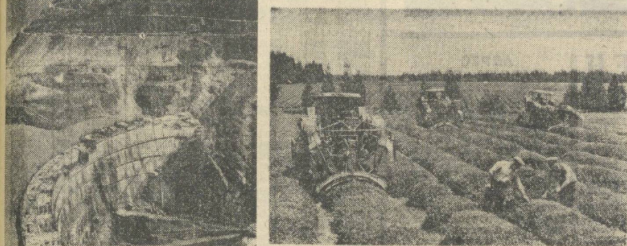
На снимках: проектная выработка — 2 миллиарда 855 миллионов киловатт-часов электроэнергии — достигла самая крупная в Закавказье Ингульская ГЭС. Гидростроители ударными темпами продолжают возводить самую высокую в Европе арочную плотину, которая должна подняться до отметки 271,5 метра. Сейчас ее высота 230 метров; на зеленых плантациях, раскинувшихся на холмах и в долинах почти на 70 тысяч гектаров, идет чайная страда.
