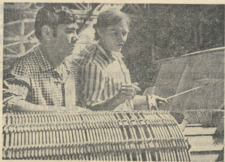
35 видов электротрансформаторов изготавливает Чирчикский трансформаторный завод. Большая часть продукции завода отмечена государственным знаком качества. На снимке: передовые монтажники, занятые сборкой сердечника трансформатора. Эмирли Динапаров и Сергей Крутов. Этим мастерам высокой квалификации доверен монтаж нового вида мощного трансформатора. Фото В. СИРОТКИНА.
