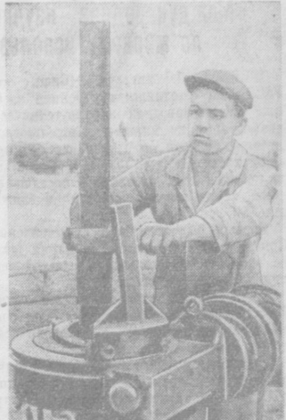
На нефтепромысле «Ходжибад» управления «Андижаннефть» установлен аппарат системы лауреата Сталинской премии Молчанова. Этот аппарат облегчает труд и ускоряет на 30 процентов работу бригады подземного ремонта нефтяных скважин. На снимке: бригадир подземного ремонта Ходжибаев Назырджан у аппарата Молчанова.
