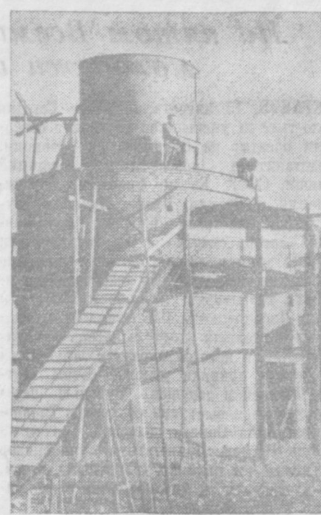
В сельхозартели «Северный маяк», Урта-Сарайского района, заканчивается строительство силосной башни емкостью в 200 тонн. Здесь же построен новый коровник на 110 голов. На снимке: строительство силосной башни.
