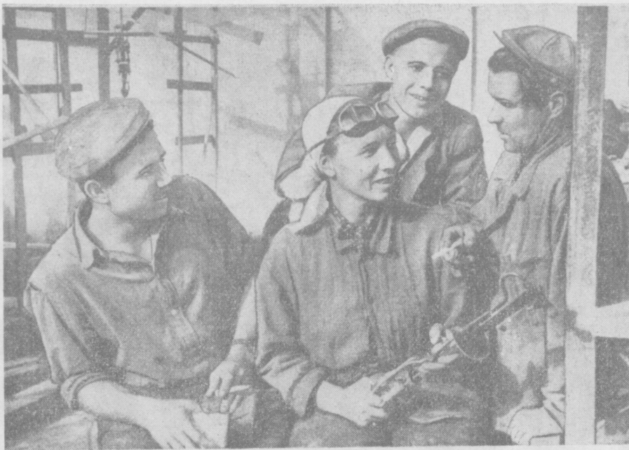
Больших успехов в предостройном социалистическом соревновании добились монтажники строительного управления УНР-979 в Дензу. Бригада монтажников, возглавляемая Е. Л. Осиним, ежедневно выполняет производственное задание на 160—170 процентов. НА СНИМКЕ: монтажники А. Н. Гуманский (слева), Г. И. Логинов, электросварщик и автогенщик Е. Д. Романов и бригадир Е. Л. Осин (справа).
