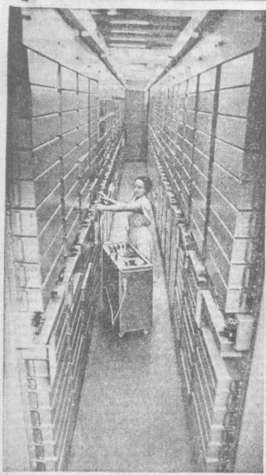
В системе ташкентских телефонных станций АТС-5 — новая, ей предстоит полугода. Рассчитана она на 10 тысяч номеров, задействовано уже шесть тысяч. Темпы освоения новых каналов связи позволяют вводить остальные номера ускоренно, чем намечено. На снимке: инженер проверочно-контрольной аппаратуры Дина Шарифамова за работой.
