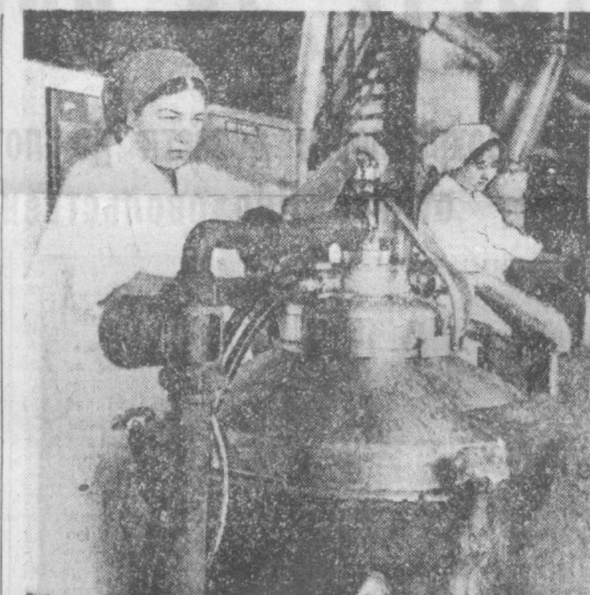
Для увеличения производства продукции на Ташкентском мясокомбинате ведется реконструкция технологических линий. Так, идут и завершены работы по монтажу второй линии рафинирования масла. На снимке: передовые работники рафинеры Т. Бакирова и И. Ахмедова.
