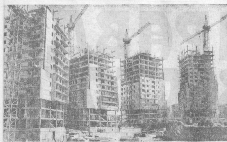
На улице Пушкина возводятся жилые комплексы, состоящие из четырех 19-этажных домов. Строительство его ведет коллектив СУ-220 московского государственного ордена Ленина и ордена Трудового Красного Знамени треста «Мосжилстрой». Завершение работ комплекса намечено 30 декабря этого года. Ввод его в эксплуатацию станет подарком таджикам в честь 60-летия образования СССР. На снимке: строительство московского жилого комплекса в Ташкенте. Фото В. СЕРГОКИНА.
