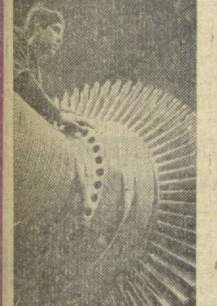
ТАМ, где до недавнего времени был пустырь, высится корпус завода. Здесь действуют три энергоблока, заканчивается монтаж четвертой машины. Это — единственная в стране станция, работающая на двух видах топлива — жидком и газе. У ротора четвертой турбины — инженер лаборатории турбин Ленинградского металлургического завода имени XII съезда КПСС Владимир Шелляпин.
