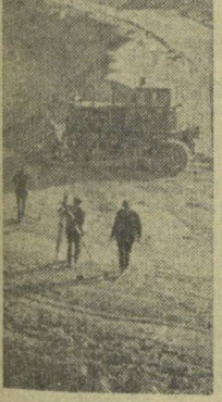
Один из участков строительства Тяньшанского гидроузла. Эта стройка — в ряду крупнейших в стране.
