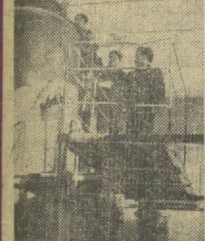
В НАЧАЛЕ нынешнего года в Намангане создан ремонтно-строительный трест. Его участники и управленцы образованы во всех районных центрах области. На снимке: слесари А. Муслимов, М. Рахимов и бригадир У. Исмаилов работают на монтаже котельной банно-прачечного комбината в Чусте.
