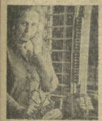
СПРАВИЛА новоселье Каршинская межрайонная телефонная станция. Оснащенная современной аппаратурой, она имеет прямой выход связи с Москвой, Ташкентом, Бухарой, Самаркандом, Душанбе. На этом снимке вы видите старшего техника станции М. Степанову.
