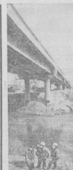
Самые крупные водные преграды — каналы Анжир и Антепа преодолели строители Ташкентского метро. Это глубоко-водные артерии, питающие водой не только поля и сады Ташкентского оазиса, но и несомненно гидроэлектростанции. Преодолевать их оказалось делом сложным. Хорошо потрудились на строительстве эстакады метро через канал Антепа монтажники М. Керимов и бригады Ю. Шадринцев из мостостроительного треста № 13, которые вы видите на верхнем снимке. Внизу — завершено строительство эстакады метро через канал Антепа. Сейчас здесь ведется подготовка к отделочным работам.
