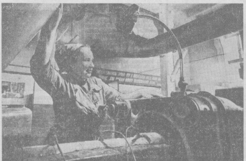
На Ташкентском заводе пластмассовых изделий и бытовой химии смонтирован и начал действовать новый технологический комплекс. На снимке: передовая производственная машинистка гранулятора Д. И. Кузьмина.
