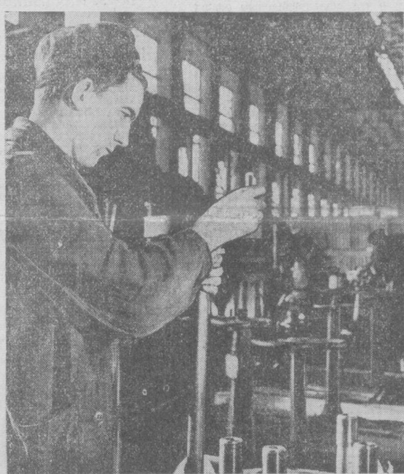
Коллектив строителей-монтажников Ахерской ГРЭС, ста на турбину вату в честь предстоящего XXII съезда КПСС, обвязав досрочно ввести в строй энергетические мощности, жилье и другие объекты. На снимке: слесари-монтажники турбинного цеха Е. Чуйкин за монтажом паропровода.
