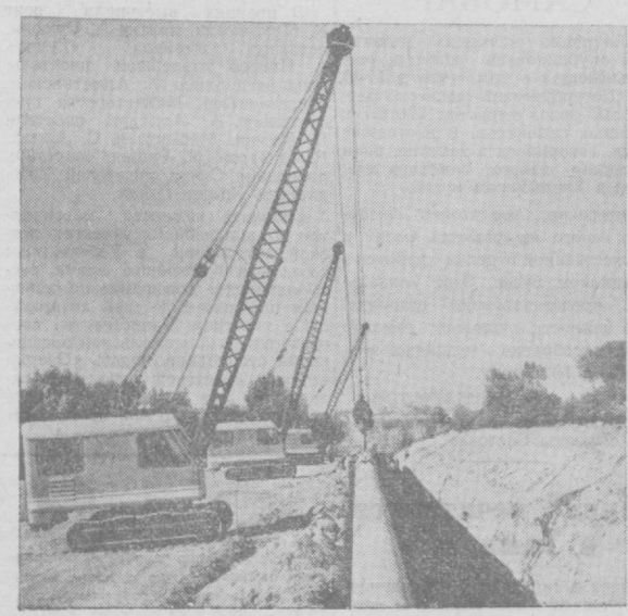
В Польской Народной Республике, в районе Плоцка, идет прокладка нефтепровода, по которому будет транспортироваться топливо из Советского Союза в Польшу и другие страны народной демократии.
