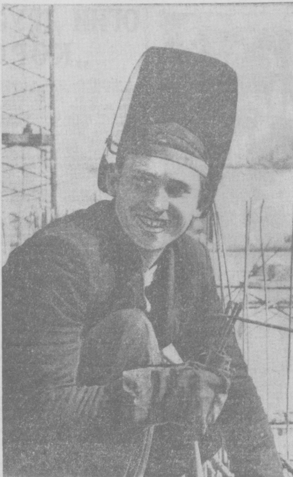
Комсомолец Владимир Федоров — передовой электросварщик из Наманганского строительного управления — с гордостью несет трудовую вахту в честь XXII съезда КПСС. Он значительно перевыполняет сменные производственные задания.
