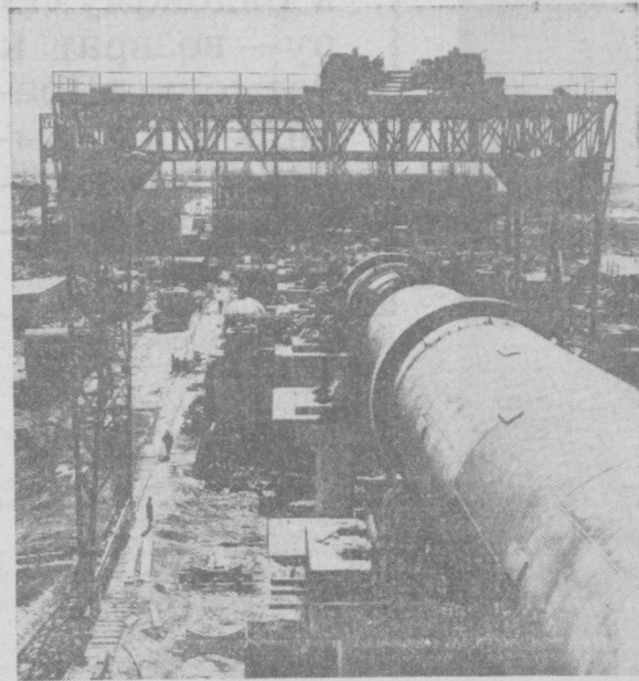
Большую трудовую победу одержали монтажники ударной комсомольской стройки семилетки — Ахматанского цементного завода. Поднят на опоры и установлен на ролики шестой блок первой вращающейся печи. Соревнование за достойную встречу XXII съезда КПСС, строители решили завершить сборку всех блоков 175-метровой печи не 12 мая, как предусматривалось обязательством, а к празднику Первомая. НА СНИМКЕ: обитый ил первой вращающейся печи.
