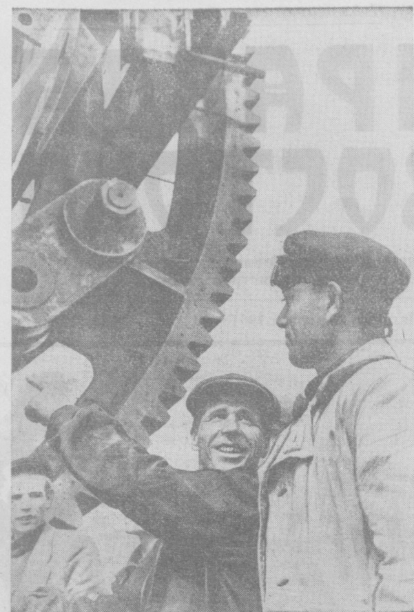
Бригада монтажников на строительстве Ахангаранского цементного завода, возглавляемая Александром Барыкиным, монтирует вращающуюся печь. В рядах бригады — комсомолец, будущий герой труда, Александр Барыкин (слева) и другие монтажники.
