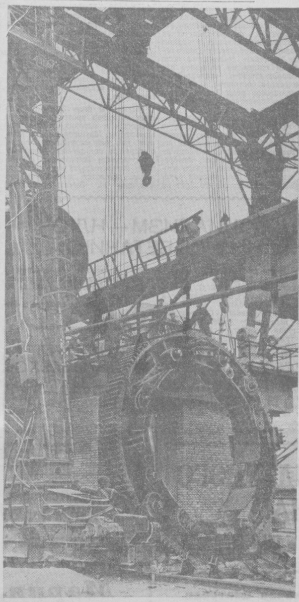
На всеобщую ударную стройку Ахунбабаевского цементного завода с каждым днем ширится социалистическое соревнование в честь XXII съезда КПСС. НА СНИМКЕ: строители готовятся к насаке венчиков шестерни на первую вращающуюся печь.
