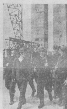
Шахта «Шахтерская-Глубокая» — одна из строителев десятилетия. Проектная мощность ее рассчитана на добычу 2,100 тысяч тонн антрацита в год. На снимке: передовые строители бригады А. П. Любенова.
