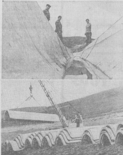
На богатырских землях колхозов и совхозов Верхнеирчиринского района началось строительство оросительных систем. По железобетонным лоткам вода будет подаваться для орошения зерновых культур, занимающих 1,500 гектаров. На снимках: сверху — первые километры лотков уже смонтированы, внизу — эти лотки еще предстоит уложить.
