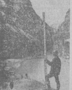
ДАГЕСТАН. Эта автономная республика, крупнейшая по площади в СССР, увеличивает свой энергетический потенциал, близ древнего аула Матлавы полным ходом идут работы по сооружению четвертой очереди станции Сулянского каскада — Митинской ГЭС. На снимке: ущелье Суляна, где будет сооружена Митинская ГЭС.
