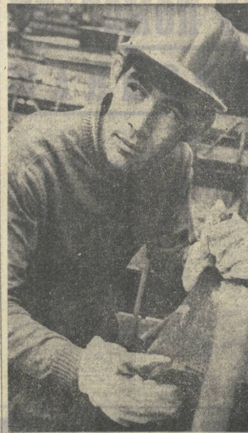
Как уже сообщалось, в Ташкенте на улице Гоголя строителями трестов № 159 и «Стальмонтаж» возводится девятиэтажное административное здание из стекла и бетона. На этом объекте хорошо трудятся монтажники Мухтар Абдулганиев, которого вы видите на этом снимке. Передовой строитель выполняет сменные задания на 120—130 процентов.
