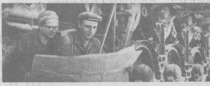
На Ташкентской бумажной комбинате ведется монтаж новой высокопроизводительной бумагоделательной машины. На ней будут вырабатывать высокосортную бумагу. Машину намерено пустить в конце первого полугодия. Передовые слесари-монтажники Юрий Яковлев и Петр Федотов, которых вы видите на этом снимке, прочитали Обращение ЦК КП Узбекистана, Президиума Верховного Совета и Совета Министров Узбекской ССР ко всем трудящимся республики, стали на трудовую вахту в честь славного юбилея республики и ее Компартии. Фото В. Сироткина.
