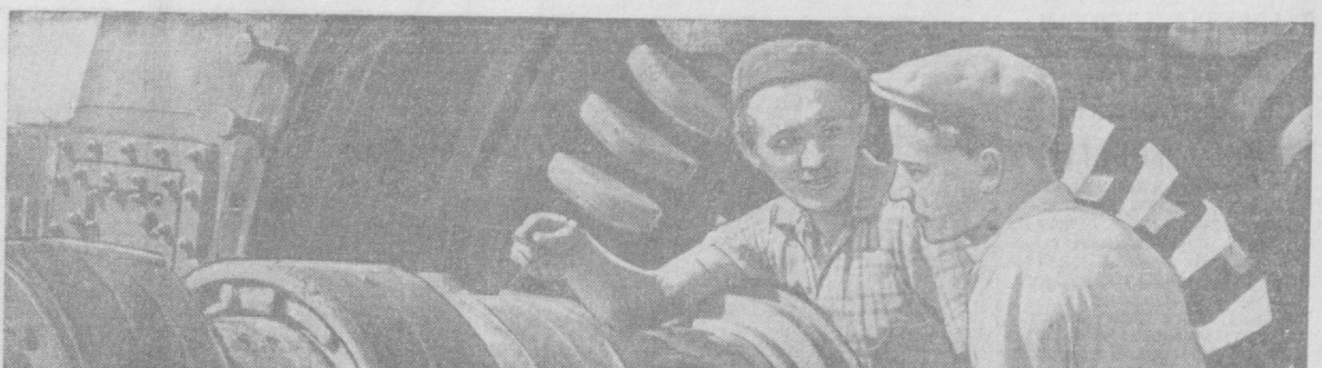
Коллектив монтажников Ташкентской ГРЭС обязался закончить монтаж агрегатов второй турбины к 10 июля. Это будет достойным подарком к 40-летию Узбекской ССР и Компартии Узбекистана. На снимке: передовые слесари-монтажники А. Лисенский (слева) и А. Булатов.
