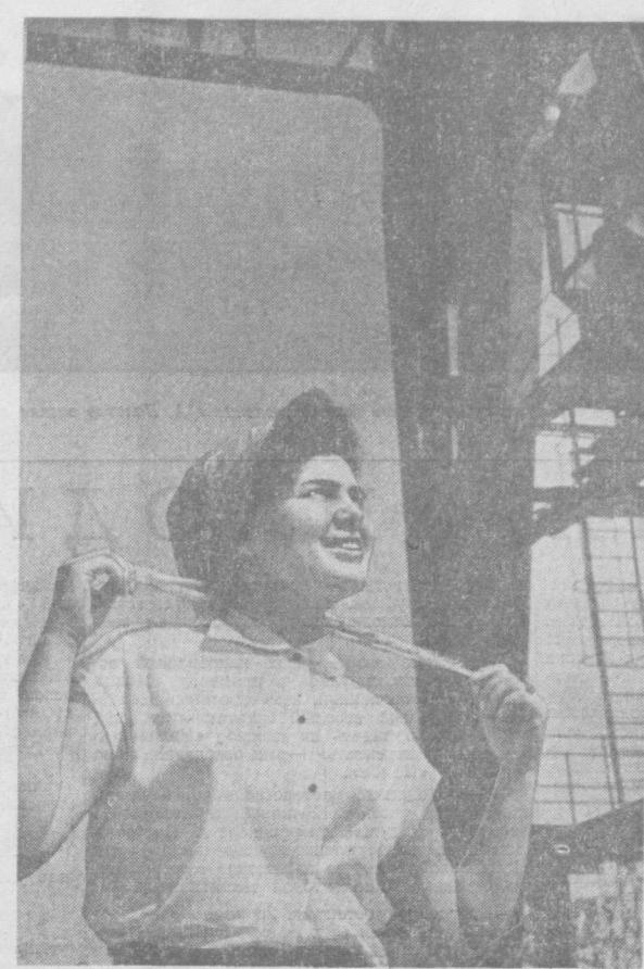
Нина Демьянова, которую вы видите на снимке, — лучшая краповица на строительстве Ташкентской ГРЭС. Работая на 60-тонном кране на монтаже опорного блока, Нина систематически перевыполняет производственные задания.
