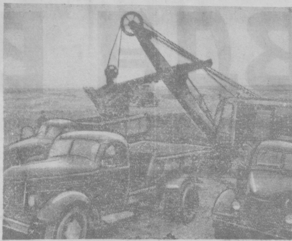
Ташкентская область. Для строительства шоссейных и асфальтированных дорог в Голодной степи необходимо большое количество гравия. Ежедневно сотни самосвалов перебрасывают ценный материал из района Хахаста к местам строительства. На снимке: загрузка экскаватором самосвалов гравием на Хахастском карьере. Фото В. Новикова. (Фотохроника УЗТАГ).
