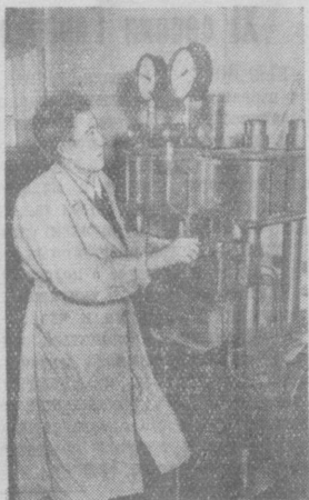
В производственно-полевой лаборатории строительства Ферганского нефтеперерабатывающего завода проводится испытание контрольных образцов бетонного завода. На снимке: старший техник-лаборант Е. К. Дещель за испытанием качества бетона. Фото И. Глауберзона.
