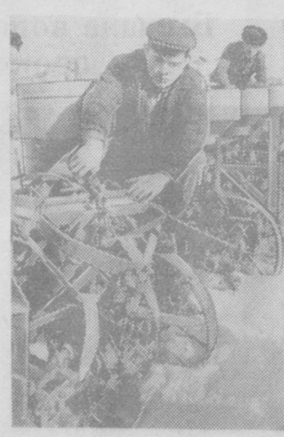
2-я Сыр-Дарьинская МТС получила 28 новых тракторов «ДТ-24-3» с хлопковыми сеялками «СКГХ-6А» и сеялками для квадратно-гнездового сева по схеме 50х50 сантиметров. На снимке: комсомолец сеялщик Николай Романенко готовит сеялку «СКГХ-6А» и навеску на трактор для квадратно-гнездового сева.
