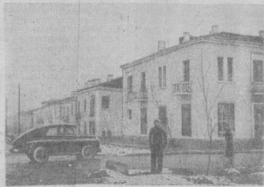
Новые жилые дома в городке суперфосфатного завода.
