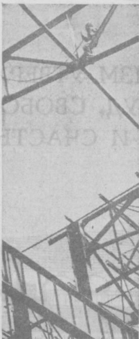
В Алматы сооружается первый в Средней Азии медеплавильный завод, который будет работать на местном сырье. На снимке: на строительстве главного корпуса.
