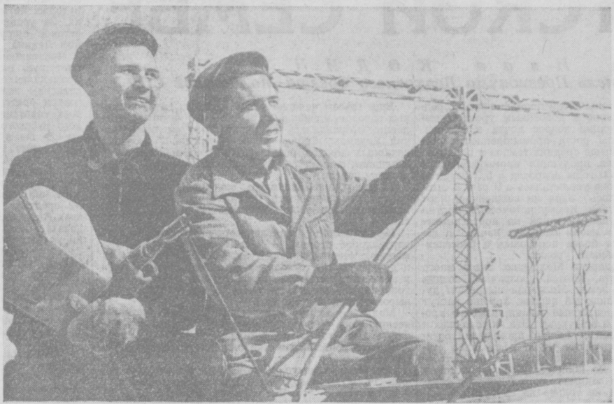
На окраине столицы нашей республики идет строительство тепловой электростанции — одной из крупнейших в Средней Азии. Коллектив строителей Ташкентской ГРЭС, став на предостерегающую вахту, стремится встретить Октябрьский праздник высокими трудовыми показателями. На нашей снимке — передовики стройки электростанции Юрий Бычков (слева) и электромонтер Валентин Сычев, систематически перевыполняющие сменные задания.
